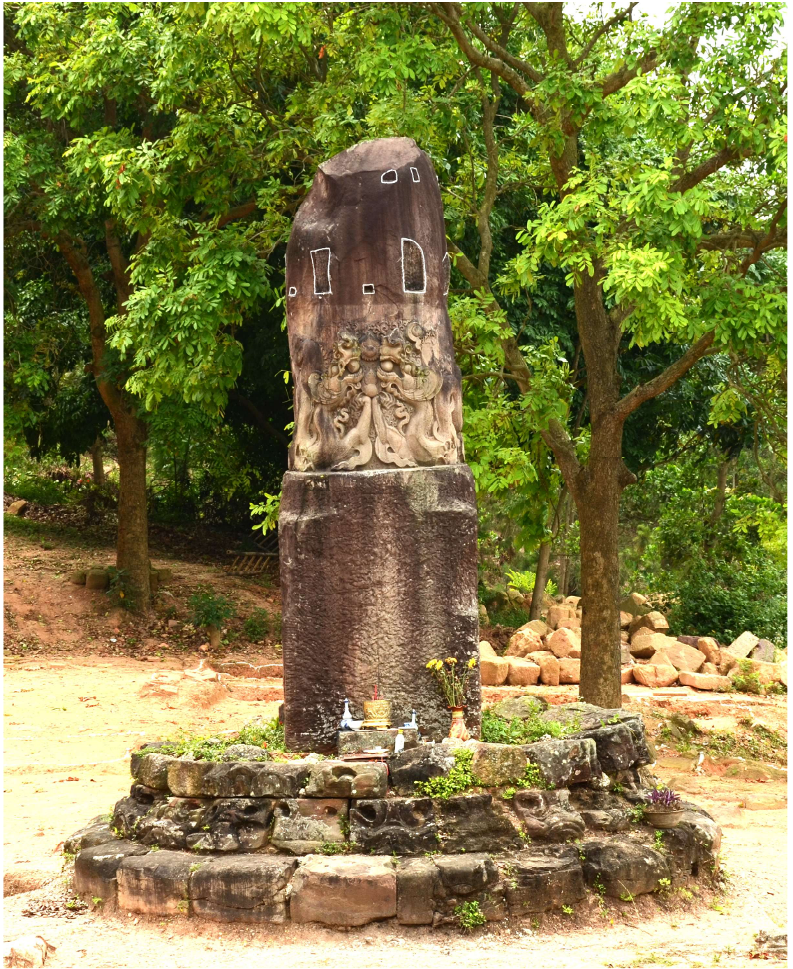
Hình 1: Hiện trạng bệ móng hình tròn đặt cột trụ đá chạm rồng Nguồn: Trịnh Hoàng Hiệp (2013)
